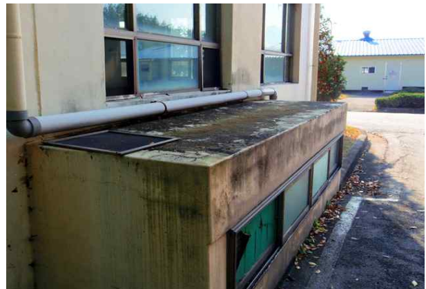
외부 환기구 표면박리 ( A=5.0m \times 1.0m )
