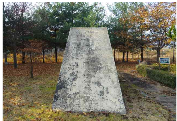
계단실 외부 벽체 콘크리트 박리 (A=2.0m×5.0m)
