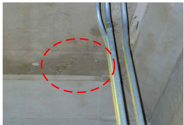
내부 지하층 천장 재료분리 ( A=0.5m \times 0.2m )
