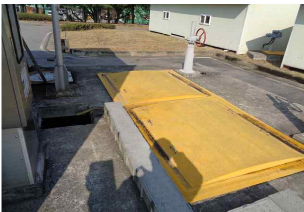
최종분배조 외부 바닥 콘크리트 표면상태 양호
