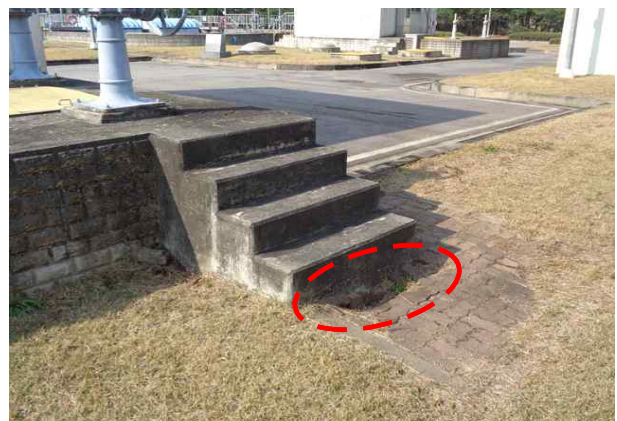
최종분배조 외부 계단 블럭침하 (A=0.5m×1.0m)
