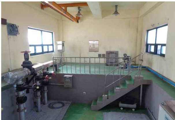
1층 내부 전경
