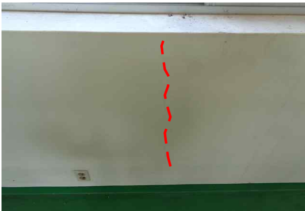
슬러지펌프장 내부 벽체 균열 (CW=0.2mm, L=1.5m)
